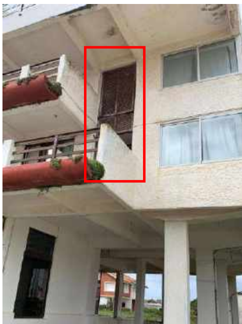
Elementos de protección en el exterior (postigones de madera con falta de mantenimiento) y en su interior (lona) - Hotel en Balneario Costa Azul. Departamento de Rocha
