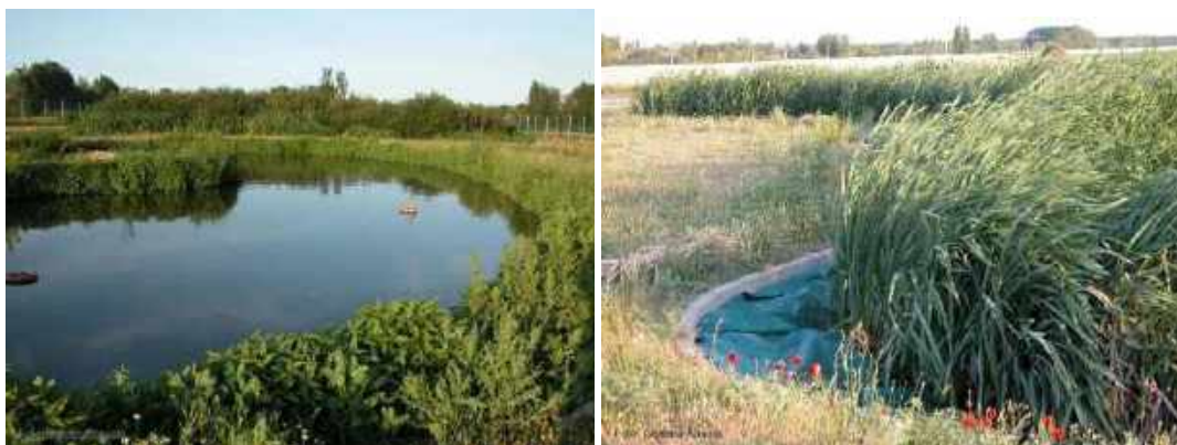
Estación de tratamiento de aguas residuales de Bustillo de Cea formada por un humedal artificial Comunidad Autónoma de Castilla y León, España
