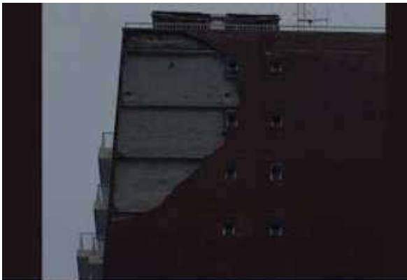
Viento desprendió ladrillos de fachada-Edificio del Triángulo 9 de agosto 2018. Punta del Este- Maldonado
