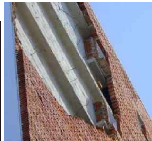
Viento desprendió ladrillos de fachada-Edificio del Triángulo 9 de agosto 2018. Punta del Este- Maldonado
